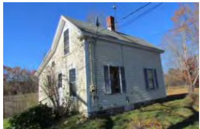
Hadley House (DCR)
