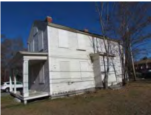
Hadley House (DCR)
