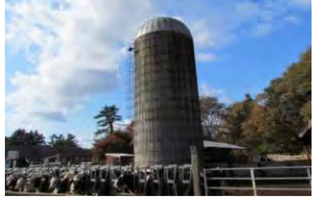
Metal Stave Silo (DCR)
