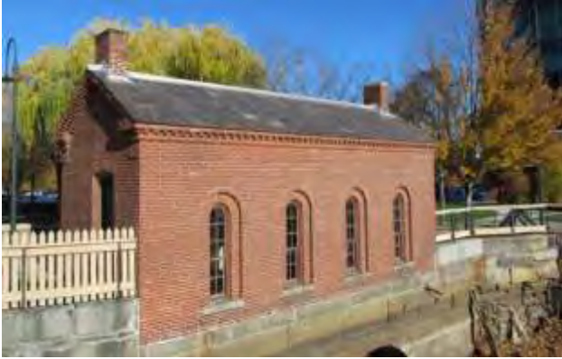
Tremont Gatehouse (DCR)
