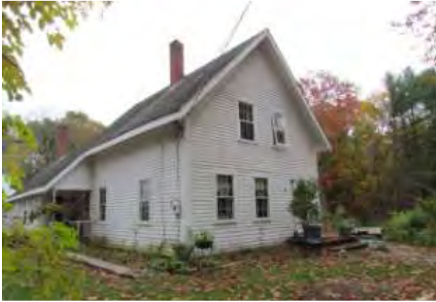
Litchfield House (DCR)
