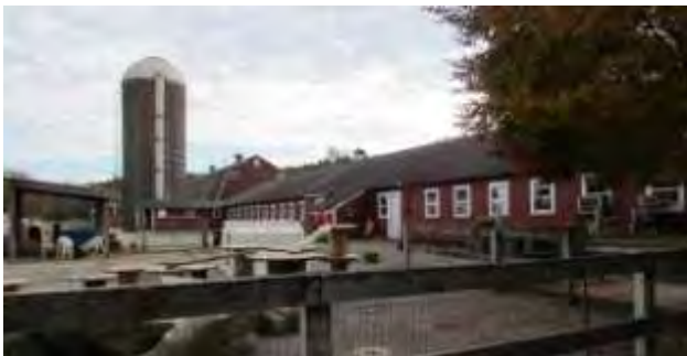
Tie Stall Barn (DCR)
