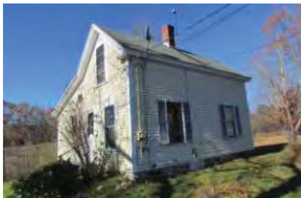
Hadley House (DCR)
