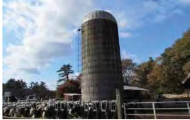
Metal Stave Silo (DCR)
