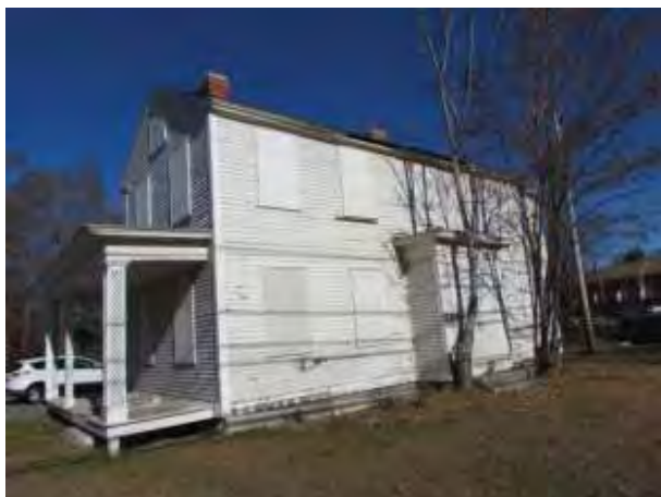
Hadley House (DCR)
